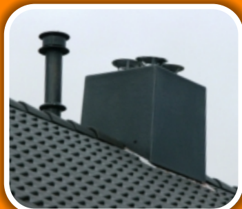
Polyester renovatie overzetschoorsteen.
