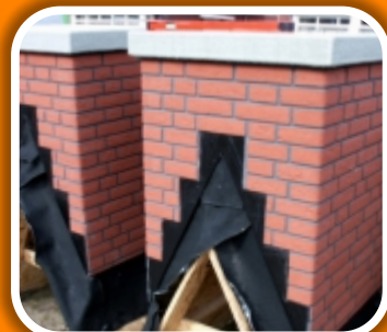
Overzetschoorsteen met steenstrips.
