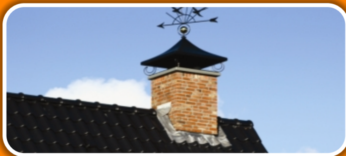
Nok schoorsteen met gezaagde steenstrippen, 15pnd lood en met sierkap.
