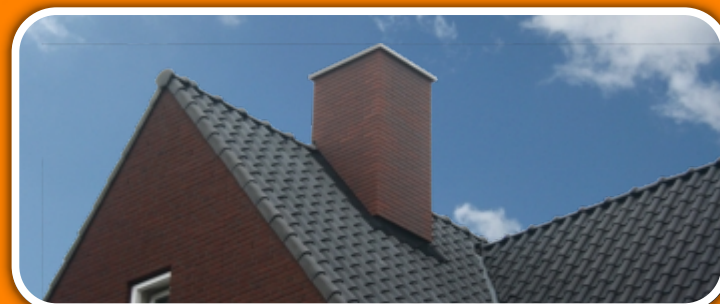
Een dakvlak schoorsteen met antracietgrijze voeg.
