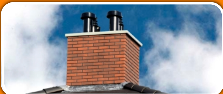
Composiet steenstrips, (polyester) betonplaat met doorvoeren op een tentdak.
