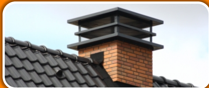
Composiet steenstrips en een aluminium niveaupak met (anti) vogelgaas.
